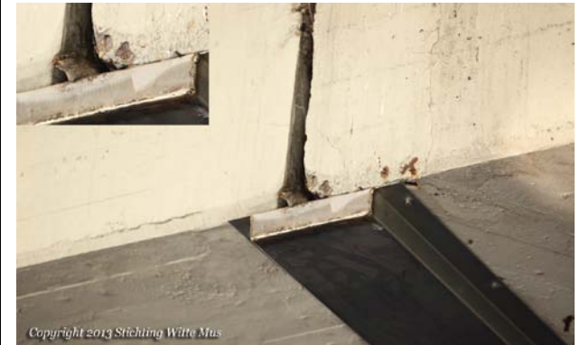
foto: Liset Karman - nest in dilatatievoeg viaduct Schiphol
